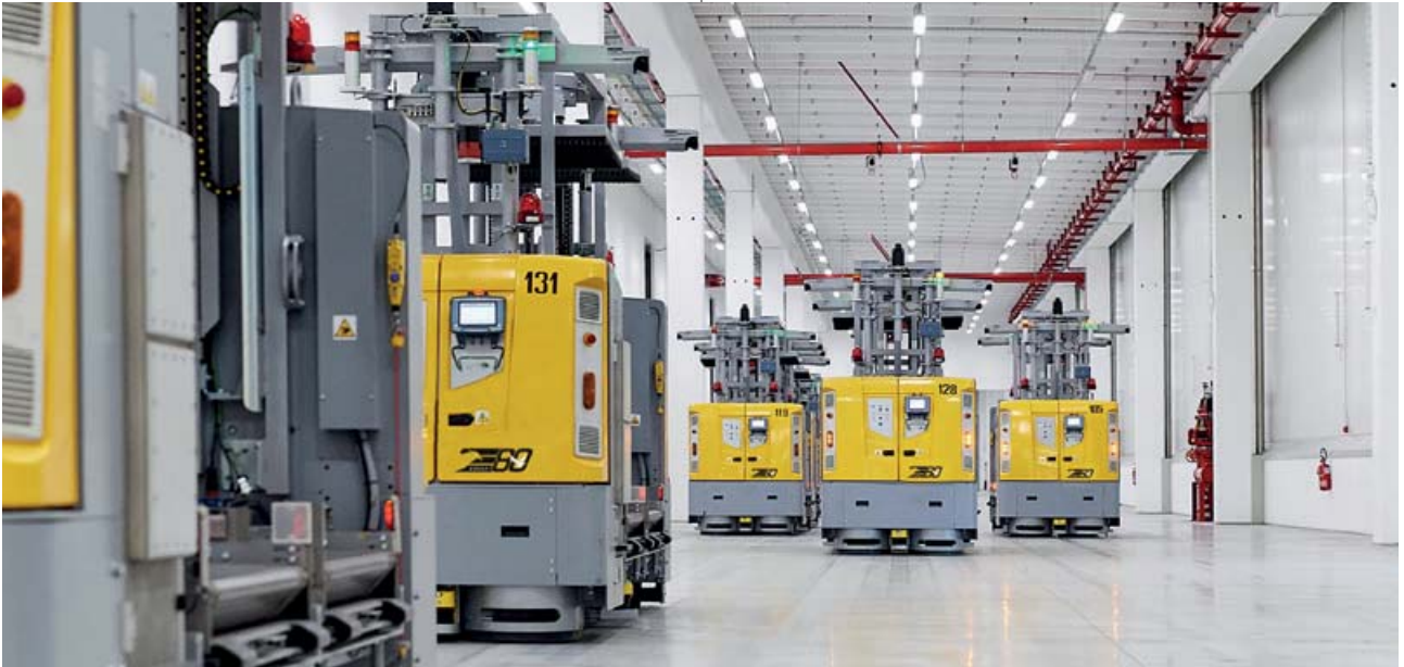
Flotta di LGV nella Smart Factory di Barilla - E80 Group
