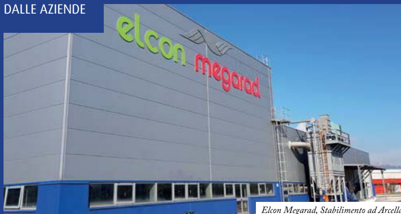
Elcon Megarad, Stabilimento ad Arcella
