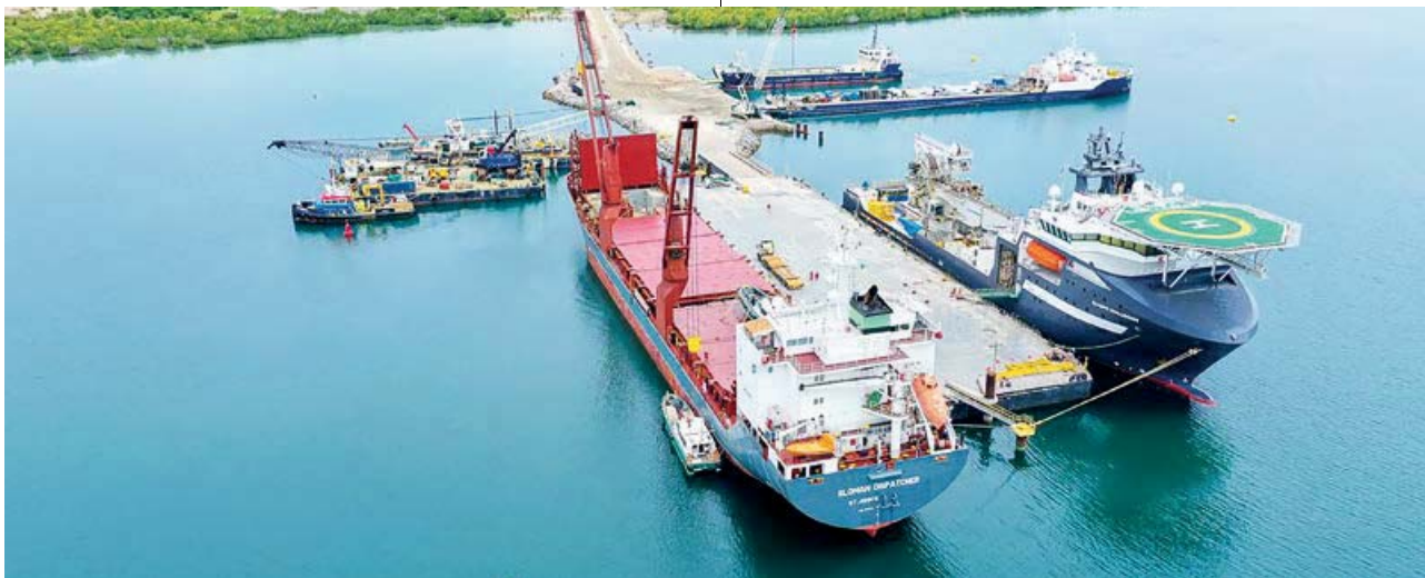
Base Logistica e Porto di Pemba (Mozambico). Una piattaforma logistica strategica al servizio dei grandi progetti energetici del Mozambico
